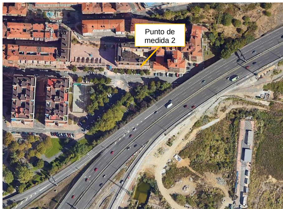
Figura 5. Ubicación del sensor acústico instalado en el punto 2.
