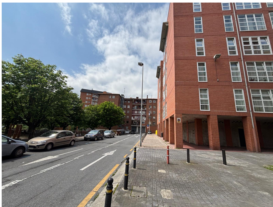
Vial y edificio calle Lurkizaga nº17
