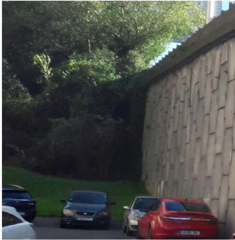
Ámbito de obra frente a edificio de la calle Etxatxu nº41
