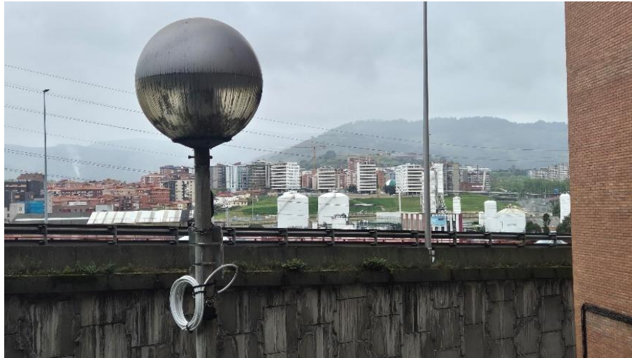
Figura 4. Vista de la zona de obras desde el punto 1.
