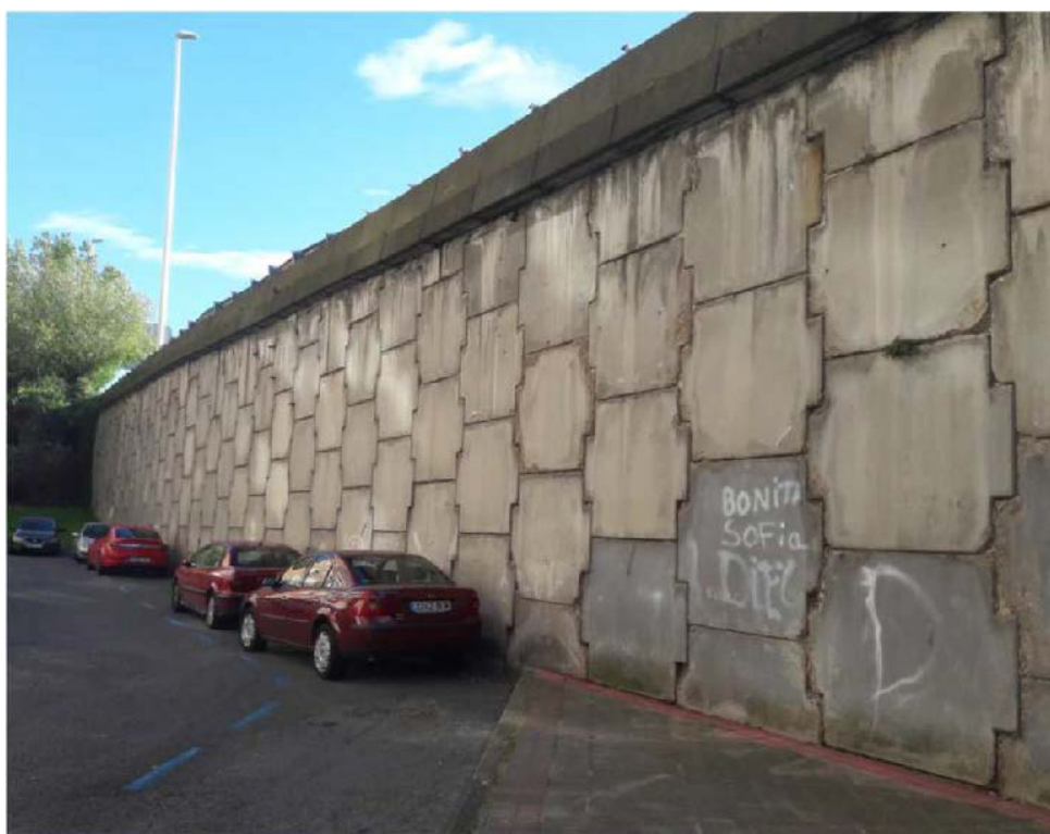
Ámbito de obra frente al edificio de la calle Etxatxu nº41
