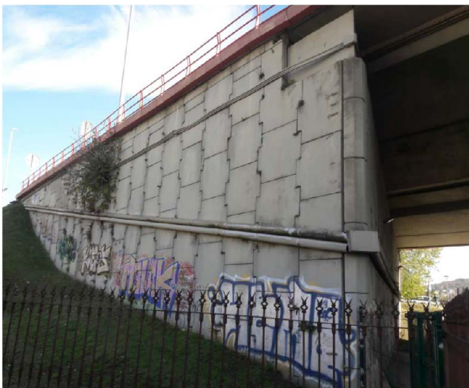
Zona de área inventariada afectada por las obras
